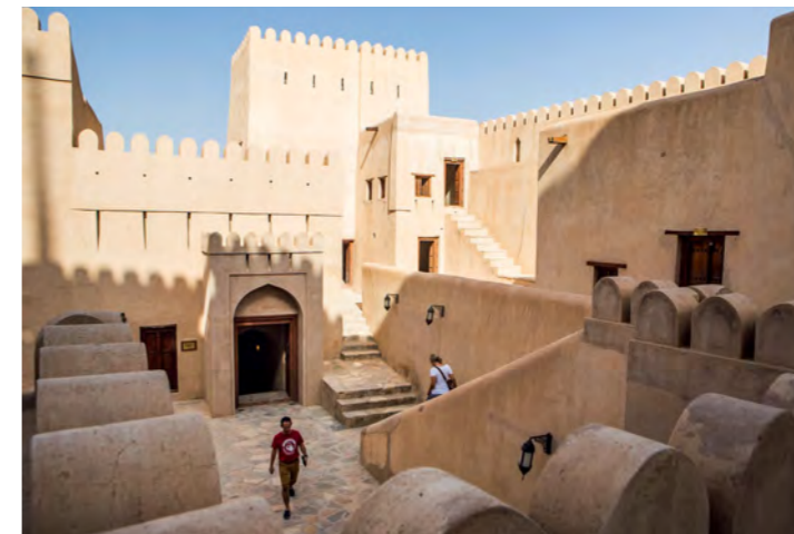
Festung: Die schönsten Bauwerke des Landes – und die besterhaltenen – sind Festungen, ganz aus Lehm gebaut. Und schön kühl im Sommer
